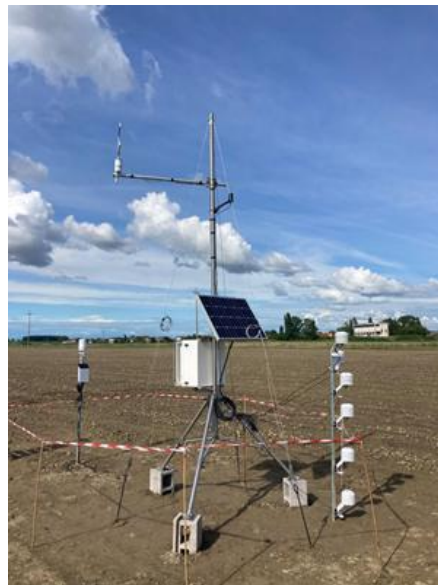
Figura 2 Stazione di misura installata presso l'Azienda "La Fagiana" per la determinazione delle principali variabili meteorologiche e dei flussi evapotraspirativi.
